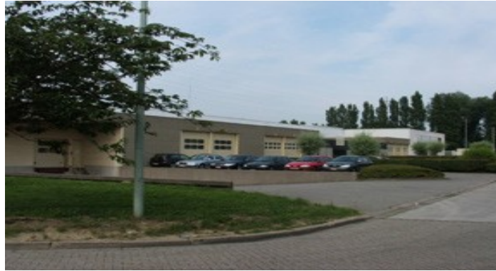
Fig 1: Kantoor en Fabriek Gudrun te Lier (B)
